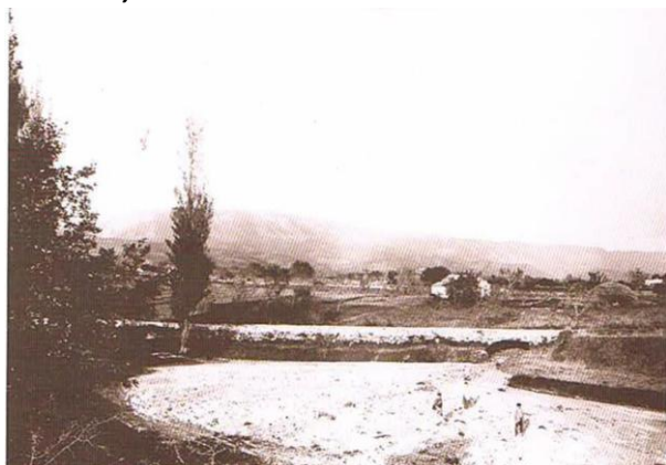
Etat du torrent de l'Ermitage au lendemain de la crue à l'aval du village de Cucuron au fer à cheval, les riverains constatent les destructions des berges et de la route qui traversait le torrent
