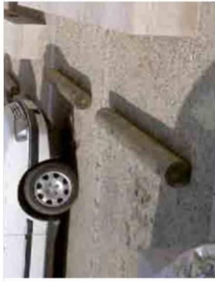
*Exemple de butée de parking rondin en pin traité autoclave classe 4 (préférer une section carrée ou rectangulaire)*
